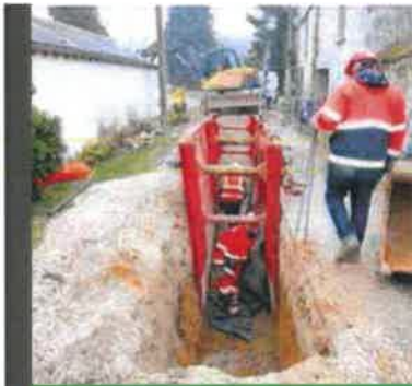
Saint-Forget : Extension d'un collecteur des eaux usées
