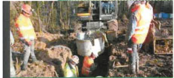
Dampierre-en-Yvelines : Création d'un réseau EU pour raccorder les habitations
