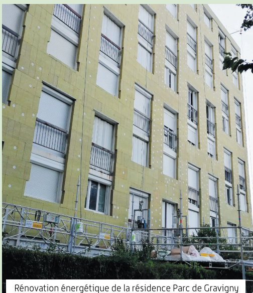
Rénovation énergétique de la résidence Parc de Gravigny
