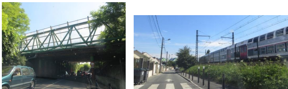
Autoroute A6 et voie ferrée (Even Conseil)
