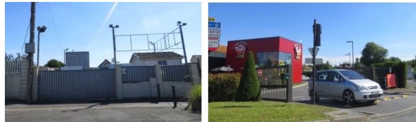
Secteur Ouest : des accompagnements végétalisés le long de certaines voies. Source : Googlemap
