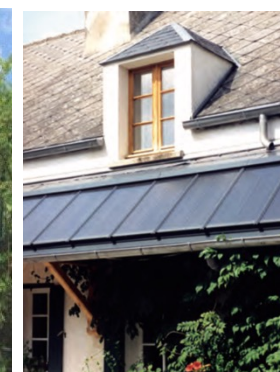
Les capteurs s'intègrent dans les protections solaires
