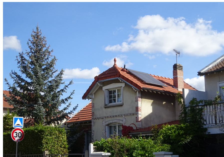
Panneaux solaires sur logement individuel (leti)
