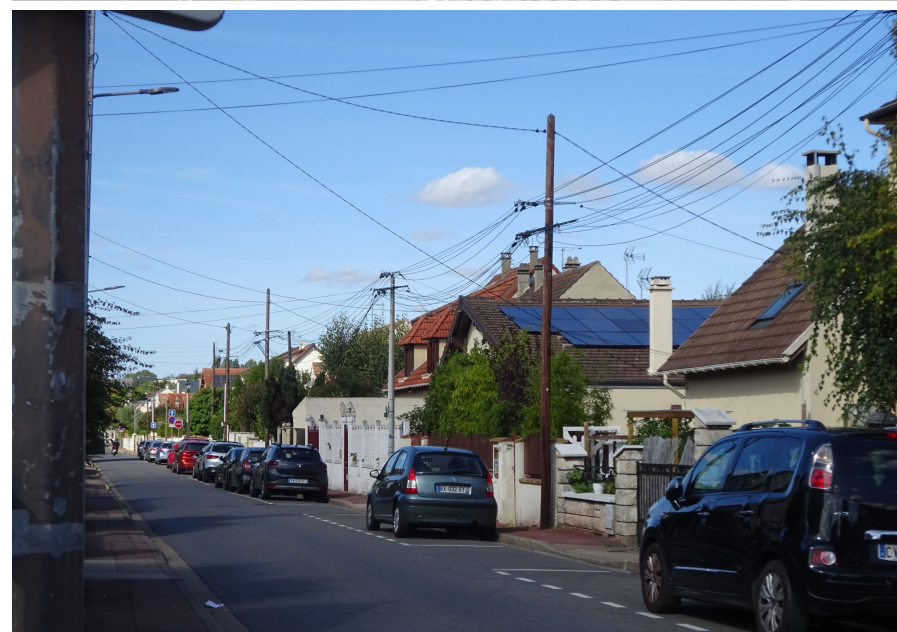
Panneaux solaires sur logement individuel (leti)
