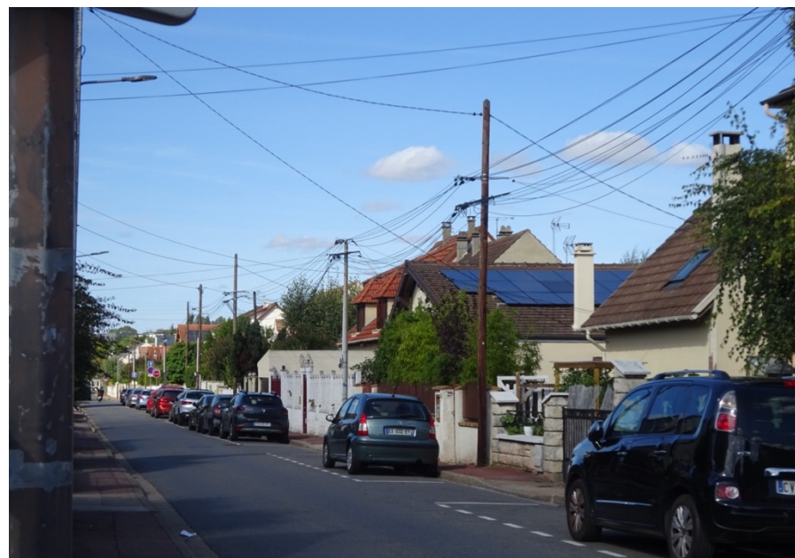
Panneaux solaires sur logement individuel (leti)
