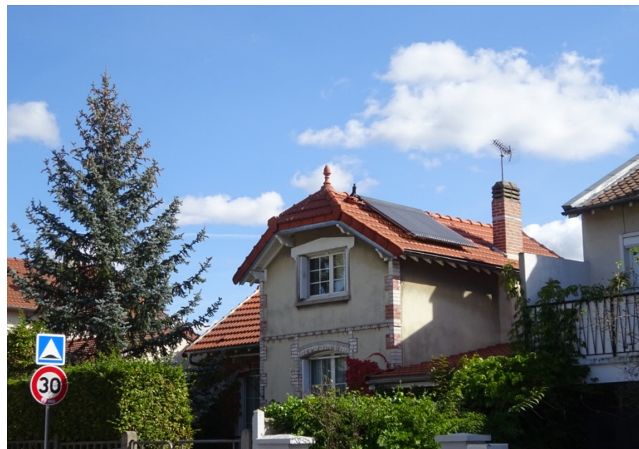
Panneaux solaires sur logement individuel (leti)
