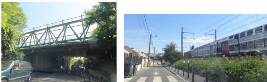
Autoroute A6 et voie ferrée (Even Conseil)
