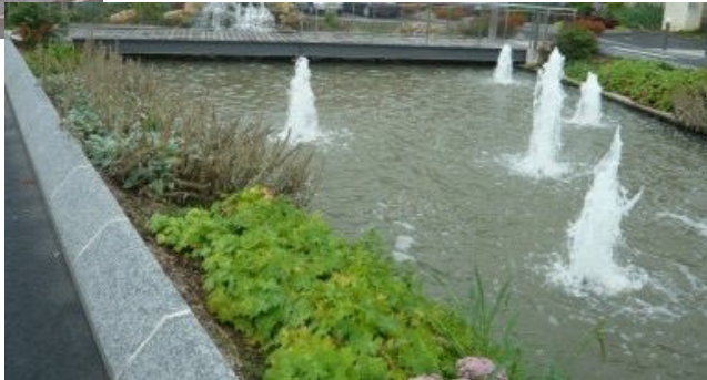
Fontaine avec réemploi des eaux pluviales (©Val de Marne)
