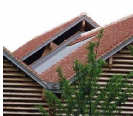
La pose de capteurs entre deux toits limite l'impact visuel.
